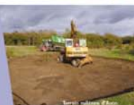
Travaux mares d'Avon
